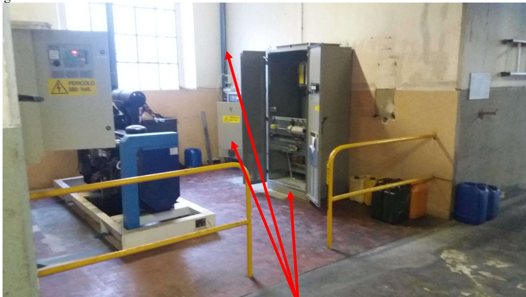
Spostare / eliminare quadri e linee elettriche
